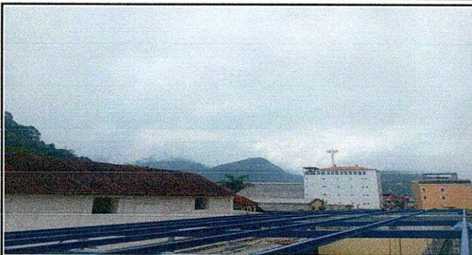
Foto: 1 Finalización de estructura del techo
