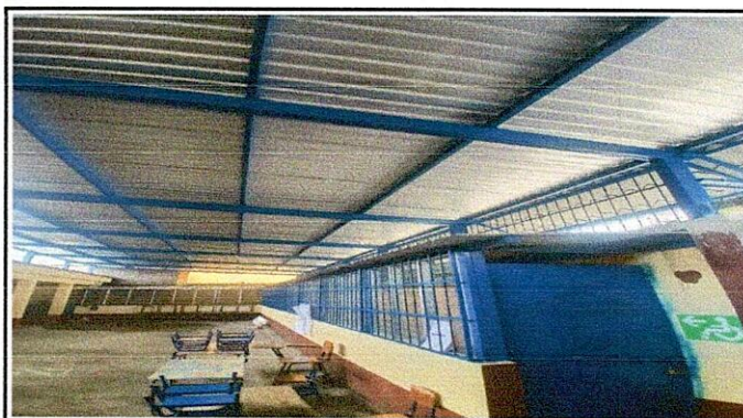
Foto: 4 Finalización de Instalación de techo con lamina troquelada
