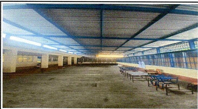
Foto: 3 Finalización de Instalación de techo con lamina troquelada
